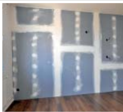
Podklad připravený pro závěrečnou malbu.
