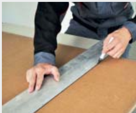
Zaměření a zakreslení potřebného rozměru desky.
